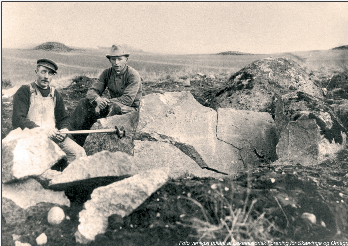
Foto venligst udlånt af Lokalhistorisk Forening for Skævinge og Omegn. Situationsbillede fra stenhugst af en dysse v. Arresø på Sjælland i begyndelsen af 1900-tallet. Dyssens store dæksten er sprængt til genbrug som skærver og bygningsmateriale. Bemærk de tre gravhøje i baggrunden som sikkert også blev genbrugt og sløjfet.
