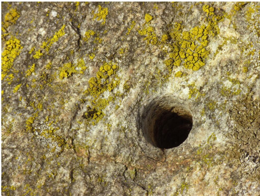
Borehul i sten ved jættestuen. Sikkert som forberedelse til krudtsprængning af stenen med sortkrudt.
