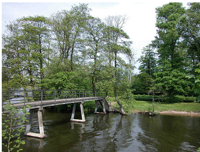
En gangbro fører over Gudenå til Slotsholmen.
