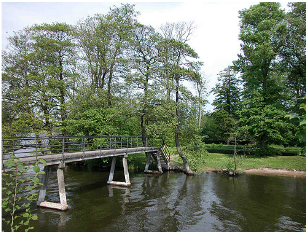
En gangbro fører over Gudenå til Slotsholmen.
