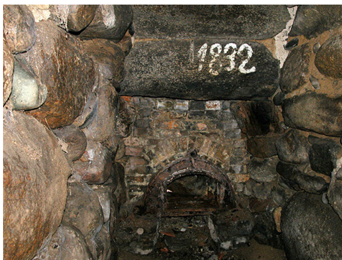
Indfyringshullet til kalkovnen i det tilstødende fyrrum.
