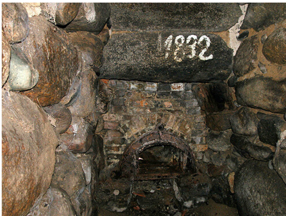
Indfyringshullet til kalkovnen i det tilstødende fyrrum.
