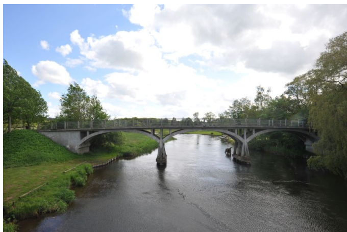
Broen set fra nord fra nutidens betonbro som i 1965 afløste biltrafik ad Amtmand Hoppes Bro.
