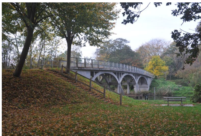
I dag indgår broen i et parkanlæg. Bemærk den store opbyggede vejdamning, som leder frem til broen.
