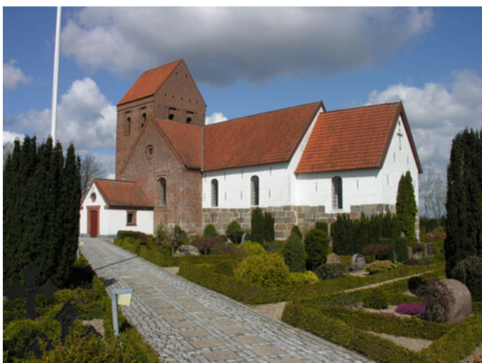
Vorbasse kirke set fra hovedindgangen i sydøst.
