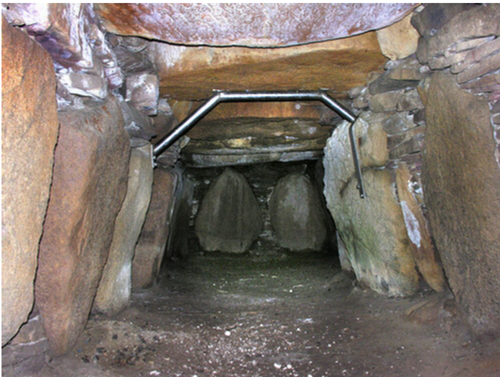
Gravkammeret set fra NØ-enden. En stålkonstruktion er opsat for at sikre dækstenen ved gangåbningen.
