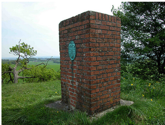
5: Det geodætiske postement på toppen af højen er et af Danmarks hovedopmålingspunkter.
