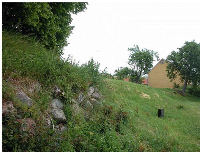
Stensætninger i nordvest-enden af byvolden.
