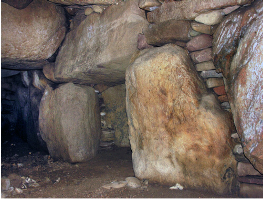
Den indre gangåbning til gravkammeret med indskudt nøglesten som fordeler trykket fra dækstenene.
