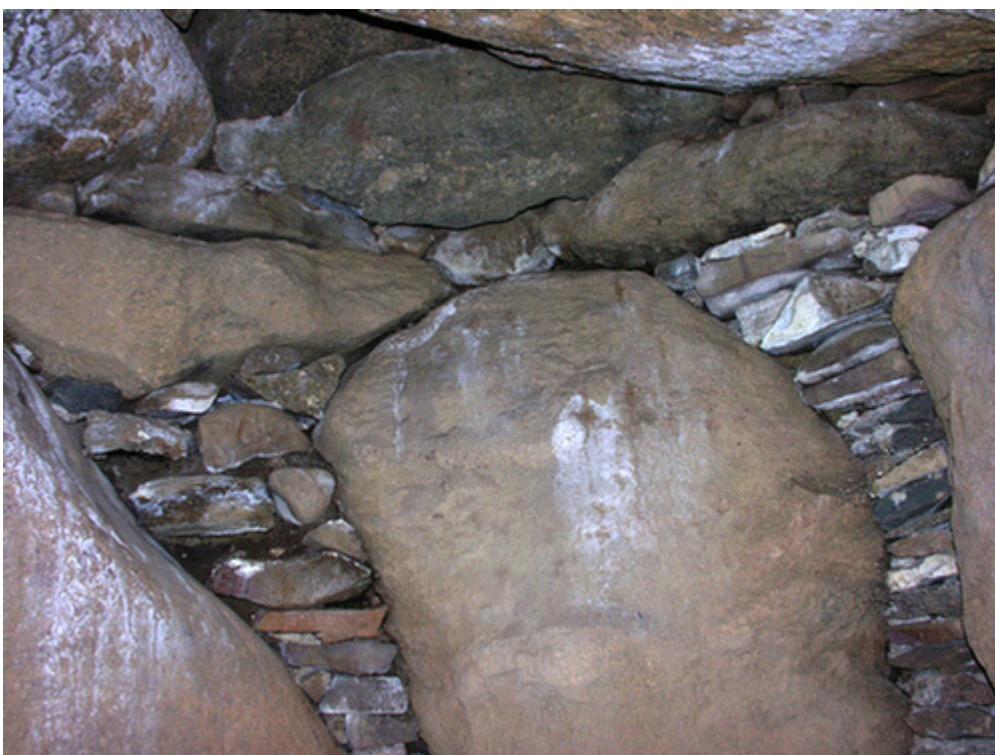
Detalje af bæresten med tørmure og de indskudte sten over bærestenen, som giver en plan flade for understøttelse af de store dæksten.
