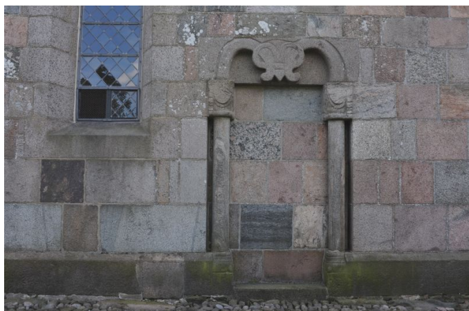
Tilmuret indgang i nordsiden.
