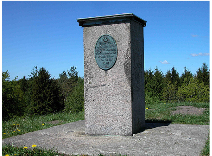
3: Det geodætiske fikspunkt på toppen af Hohøj er et af hovedpunkterne i det danske opmålingssystem.
