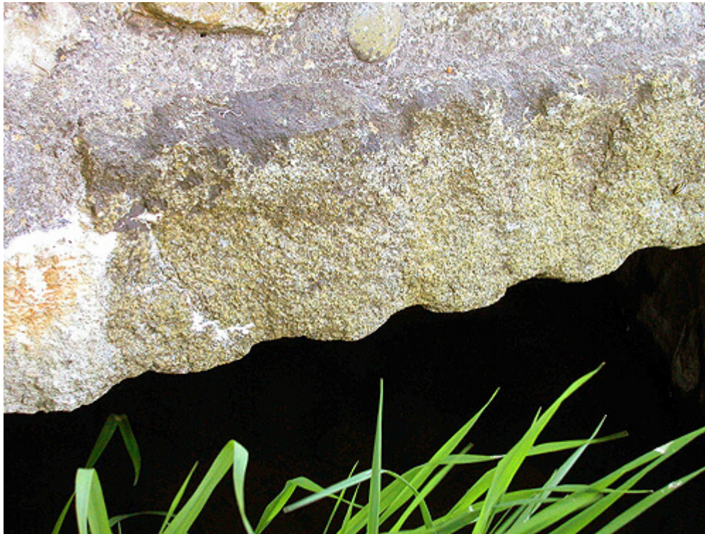
Detalje af kløvningsriller i de lange stenplanker som bærer broen.
