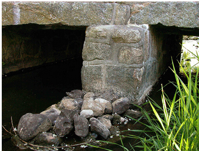
Modstrøms er broen forstærket med strømpiller.
