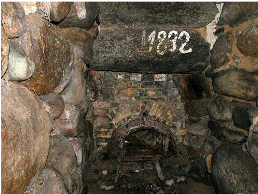
Indfyrringshullet til kalkovnen i det tilstødende fyrrum.
