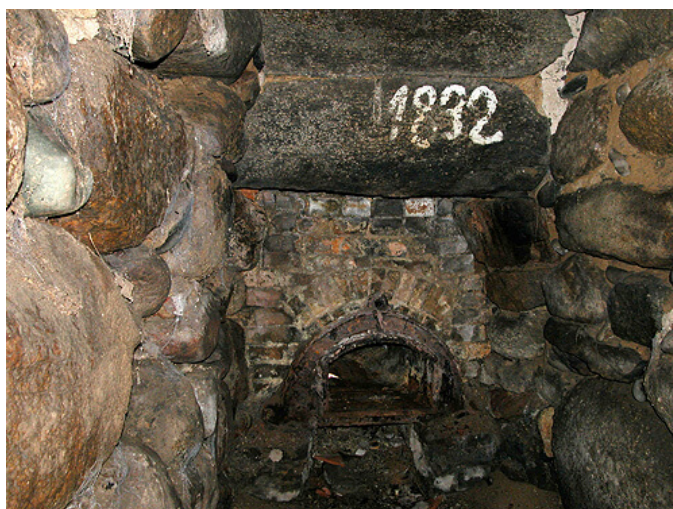
Indfyringshullet til kalkovnen i det tilstødende fyrrum.
