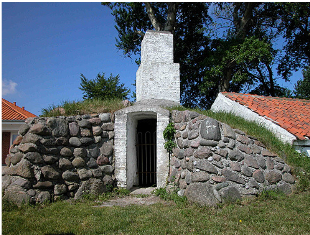
Kalkovnen set fra sydøst. Ved kalkbrænding blev indgangshullet tilmuret.
